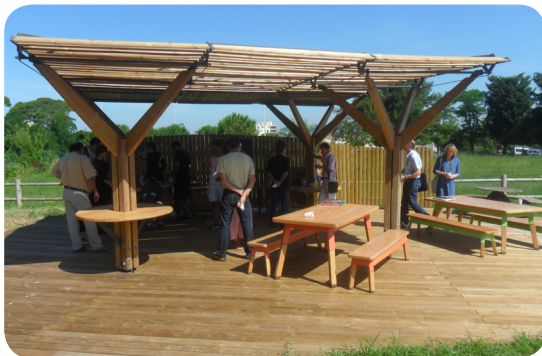
Terrasse «équipée» et cuisine solaire Ferme Pédagogique du Roy d'Espagne - 2009 et 2011 © Appel d'Aire
