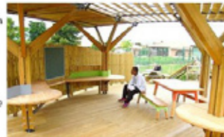
La pergola, montage achevé
