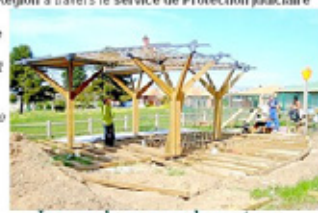
La pergola en cours de montage
